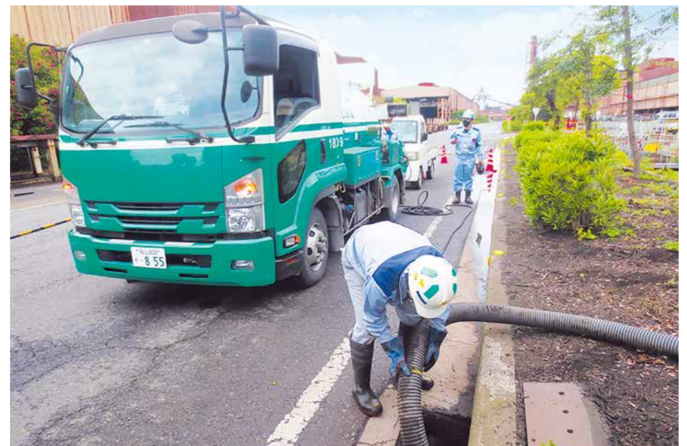
業務内容 ●工場で発生するダスト・スラジの吸引、回収・運搬作業 ●高圧洗浄車による配管・タンク内洗浄
